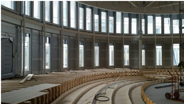
Den stora hörsalen under pågående bygge
