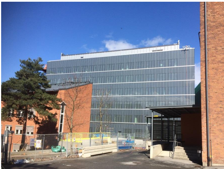
KM-B från Nobels väg, synligt mellan MTC och Wargentinhuset
