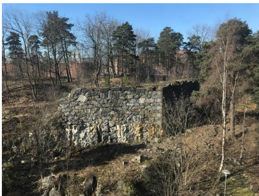
Ångcentralen får den så kallade Ryssmuren från tidigt 1700-tal som närmaste granne
