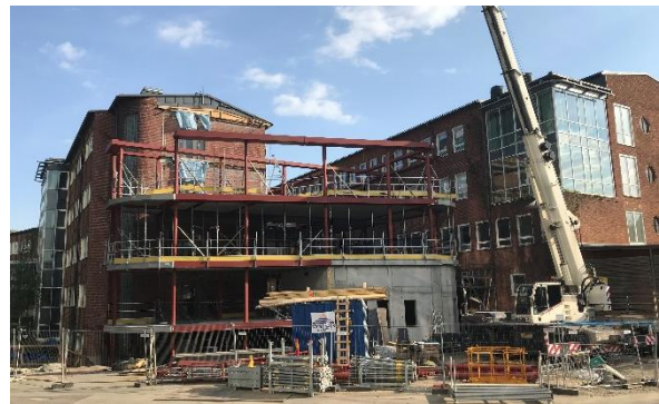
Från byggplatsen i början av maj
