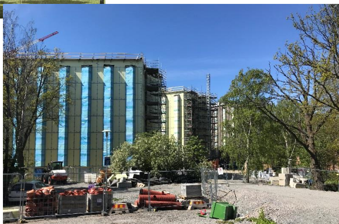
Foto från byggsplatsen
