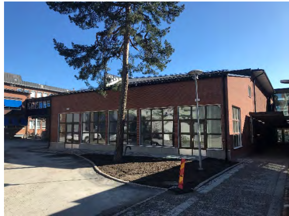
Tillbyggnad med gymlokal mot gården
